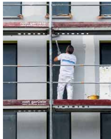
Revêtement de la façade du nouveau bâtiment de l'ASEPP
