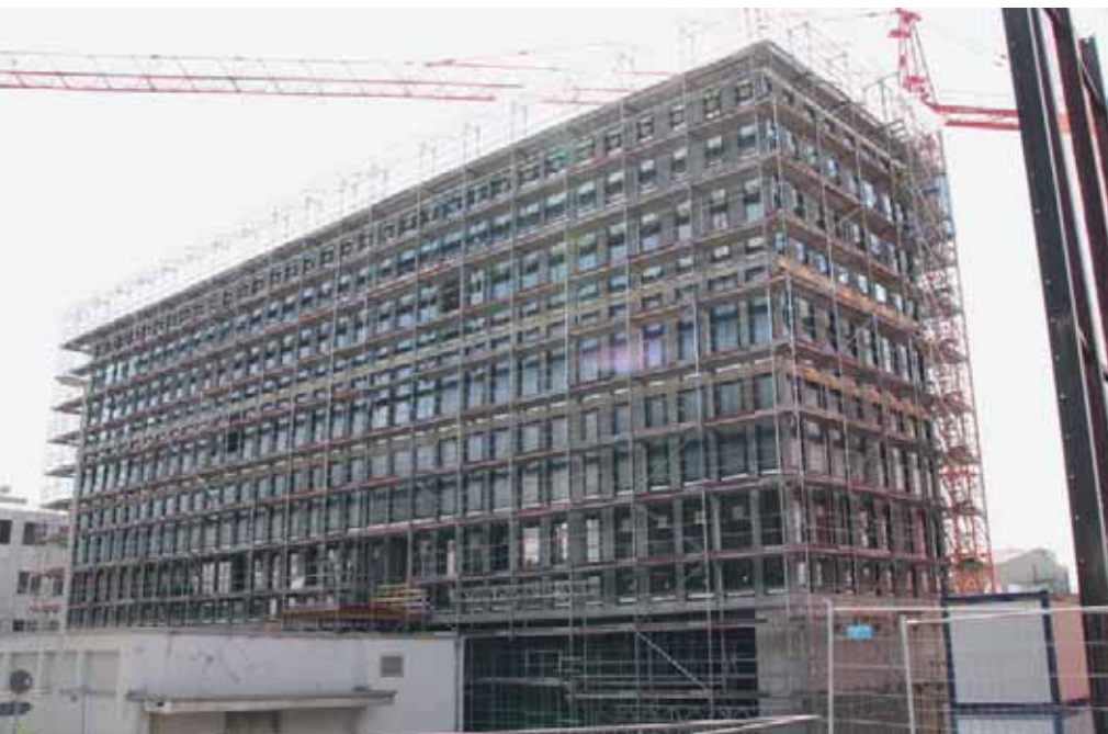
Le nouveau bâtiment échafaudé du centre de services de l'ASEPP, situé dans la Oberwiesenstrasse 2 à Wallisellen.
