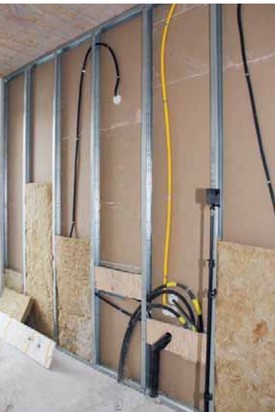
Cloisons légères avec isolation de remplissage.
