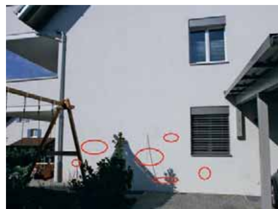
Photo 6: l'épaisseur totale de la couche prélevée (y compris crépi de finition) est de 10 mm maximum.
