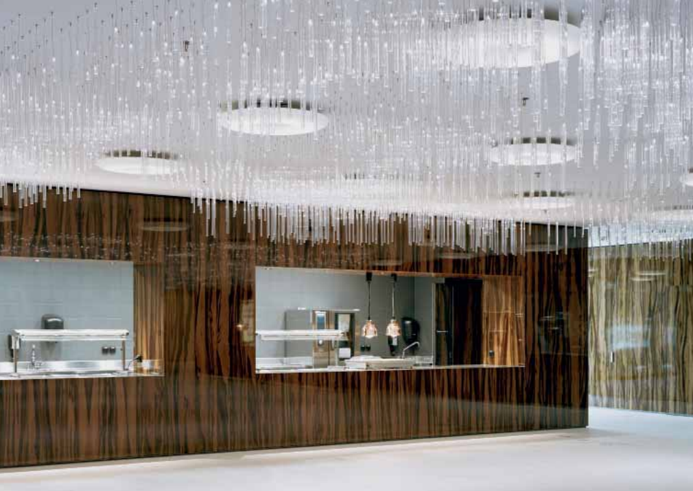
Les 4000 suspensions tubulaires sont intégrées dans le plafond en panneaux MDF, qui est encadré par un système acoustique. (Photo: Barbara Bühler)
