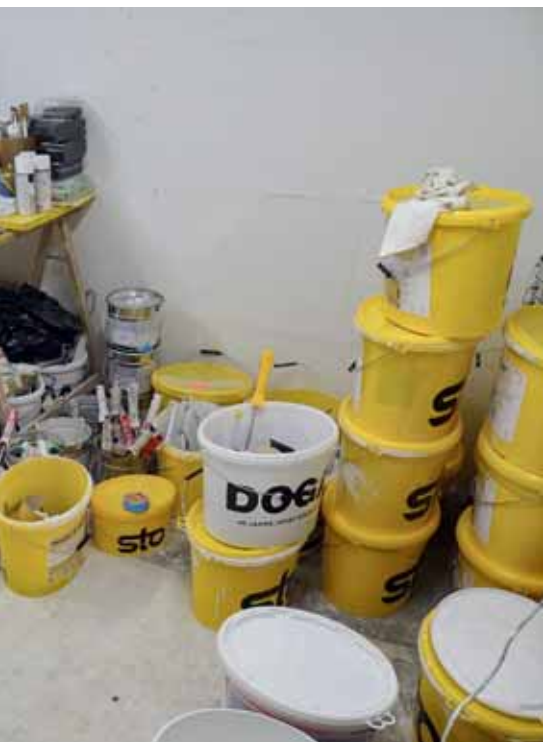
Sur le chantier aussi, les outils de travail doivent être nettoyés après utilisation.
