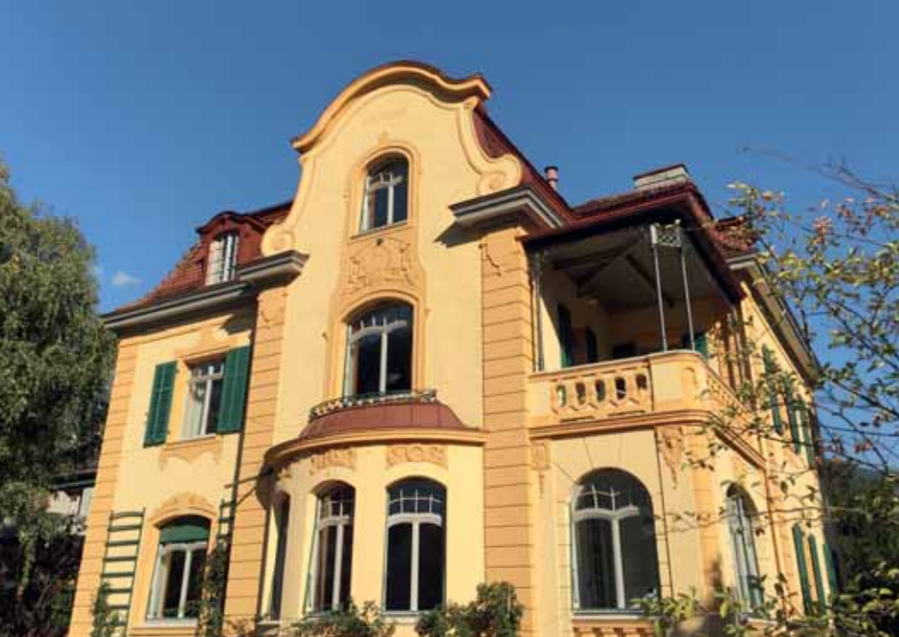
Villa cittadina a Coira. La tonalità qui ha raggiunto un valore limite per una pittura a base di calce. In questo caso però non sono apparse macchie e la facciata brilla letteralmente in una tonalità ocra soleggiata e chiara.
