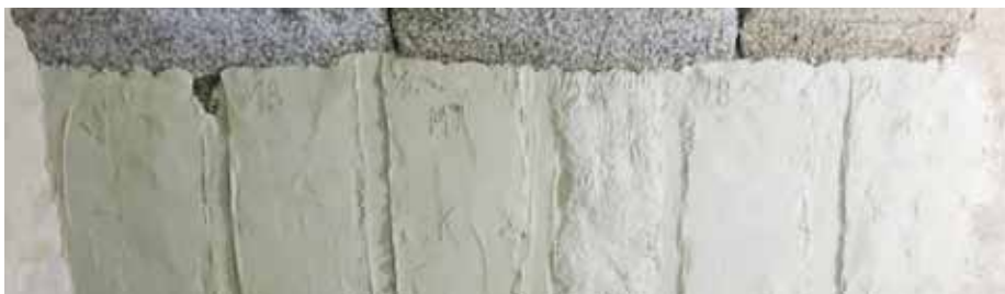
Area di test per caratterizzare l'effetto di diverse compresse di desalinizzazione.
