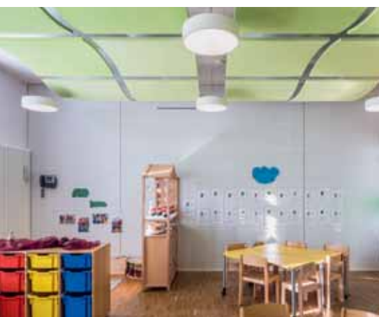
Uso di elementi acustici rivestiti in un asilo lussemburghese.
