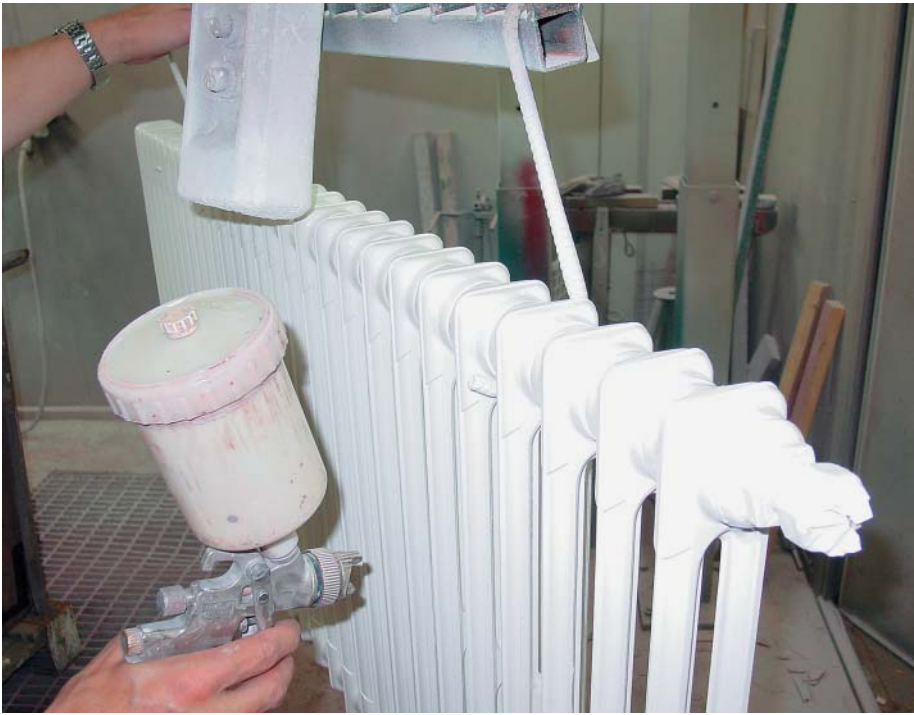
Eine Rostschutzgrundierung ist die optimale Vorbereitung für den nachfolgenden Farbauftrag.
