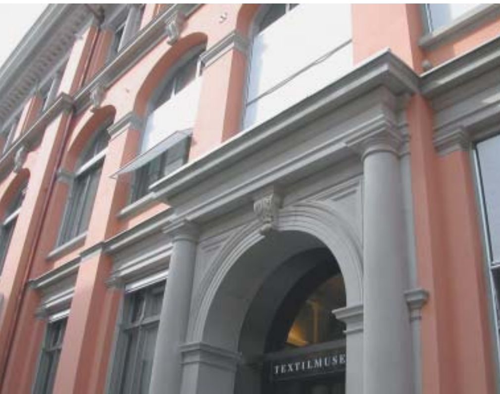
Der Eingang des Textilmuseums wirkt nach der Renovation dank einer automatischen Glastür einladend.
