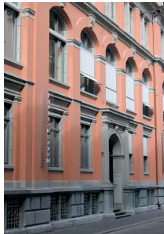
Die hohen Blendarkaden verbinden zwei Stockwerke und stehen auf einem massiven Granitsockel.
