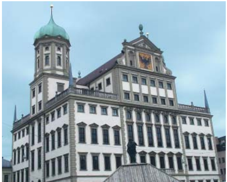
Das Rathaus Augsburg, 20 Jahre nachdem ein Reinsilikat-Anstrich mit Siloxan aufgebracht wurde.
