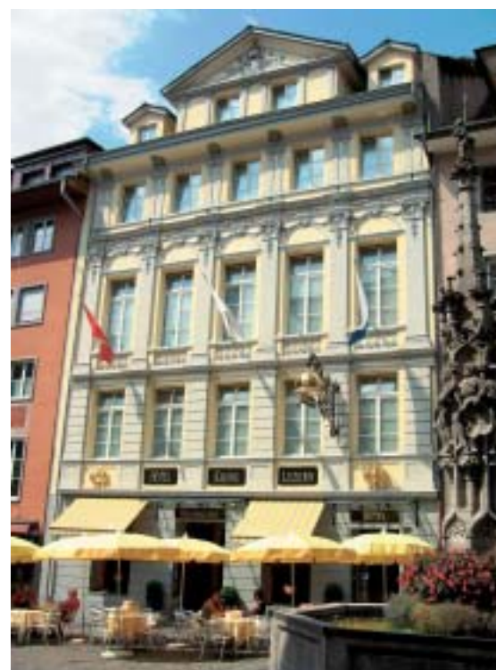
7 Eine Altstadtfassade in Luzern mit reichen Stuckaturen, 1993 mit einer Organosilikatfarbe gestrichen. Trotz vieler auskragender Bauteile sind keine Abläufer und keine erkennbare Verschmutzung vorhanden.
