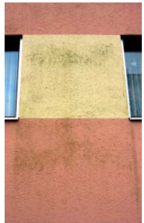
6 Schon nach wenigen Jahren bildeten sich an dem Haus in Bild 5 Abläufer sowie starker Algen- und Moosbewuchs.
