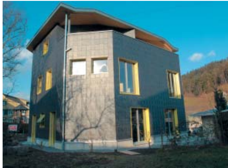
Schiefer schützt die Gebäudehülle vor sommerlicher Wärme sowie vor Wind und Wetter.
