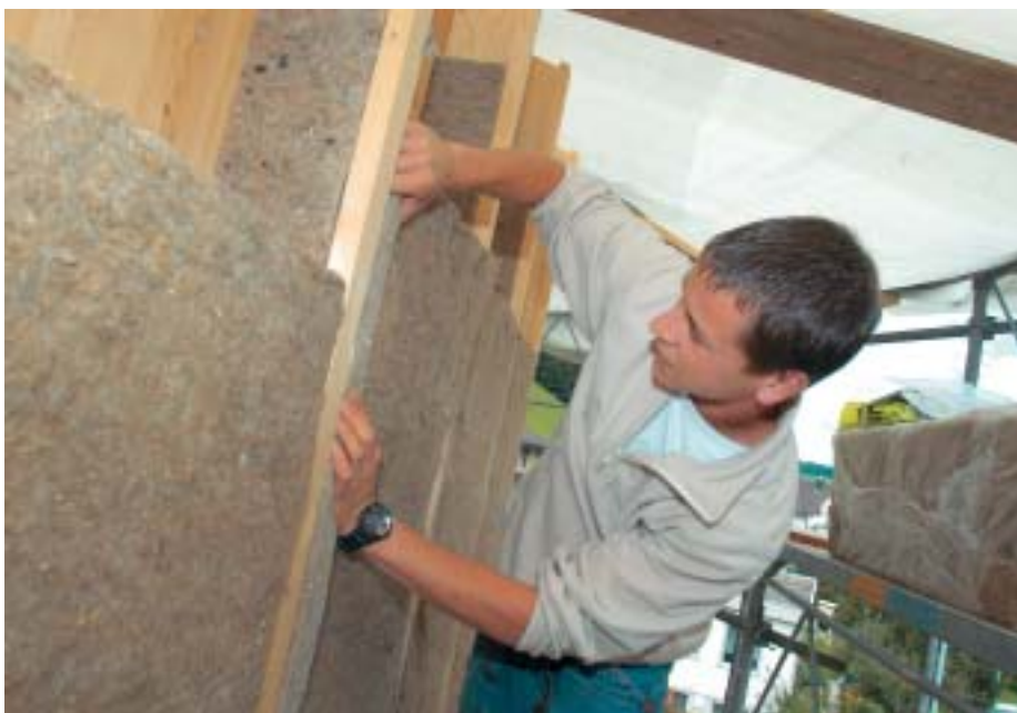
Hanf ist wie Holz ein nachwachsendes Rohmaterial. Zu Matten verarbeitet, dient er als idealer Dämmstoff.
