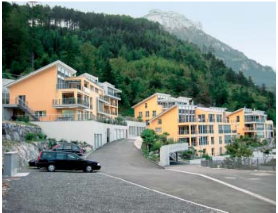
Eine nach ökologischen Grundsätzen gebaute Mehrfamilienhaus-Siedlung in Brunnen SZ, die 2001 in halbdeckender Technik mit Silikatfarbe gestrichen wurde.
