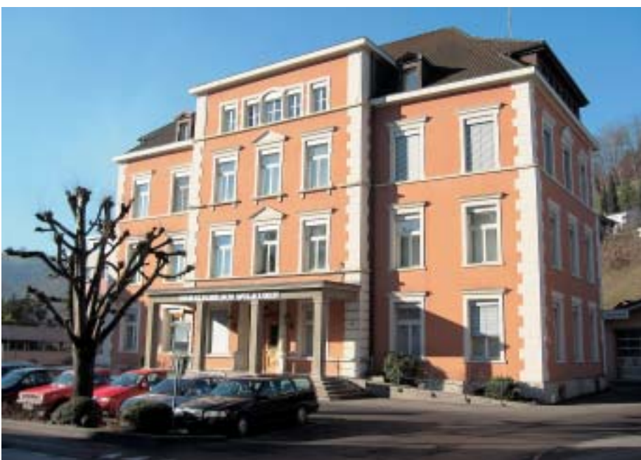
Silikatfarben haben gemäss einer 1996 durchgeführten Studie die bessere Ökobilanz als Silikonharzfarben. Im Bild eine Aufnahme des Gemeindehauses Wolhusen LU von 2005, das 1976 mit Organosilikatfarbe gestrichen wurde.
