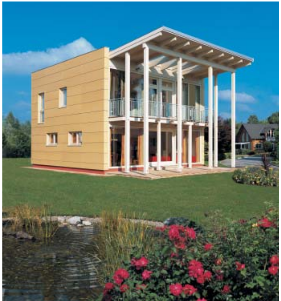
7 Cemboard-Faserzementplatten sind in der Regel durchgefärbt. Damit haben die Stirnseiten dieselbe Farbe wie die Flächen.
