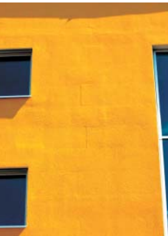
3 Abzeichnung der klaren Konturen einzelner Wärmedämmplatten.
