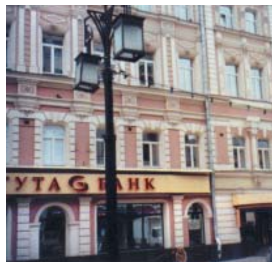
2 Eine gemäss Farbkonzept renovierte Fassade.
