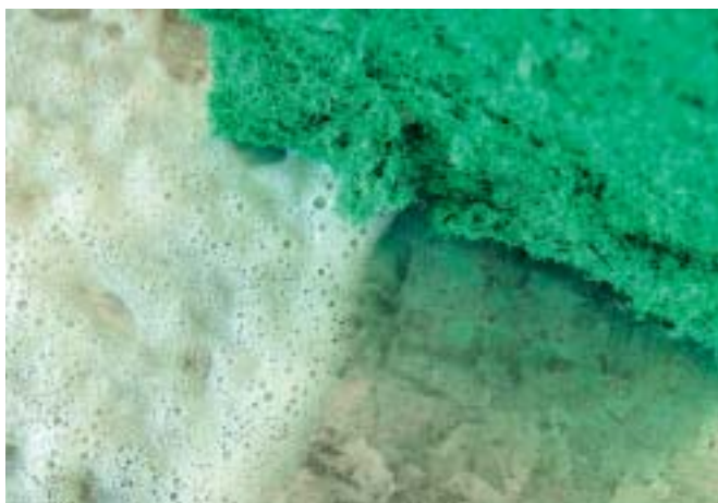
Il lavaggio con reticolante ammoniacale è il giusto pretrattamento dei fondi zincati prima dell'applicazione della vernice.
