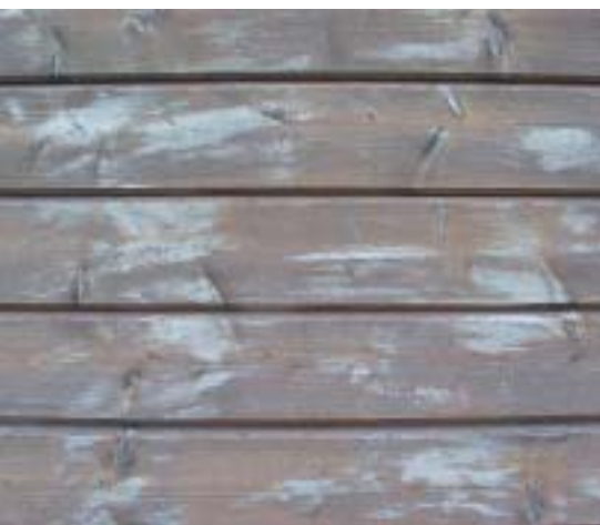
Eine verwitterte Dünnschichtlasur lässt sich mit vergleichsweise geringem Aufwand renovieren.
