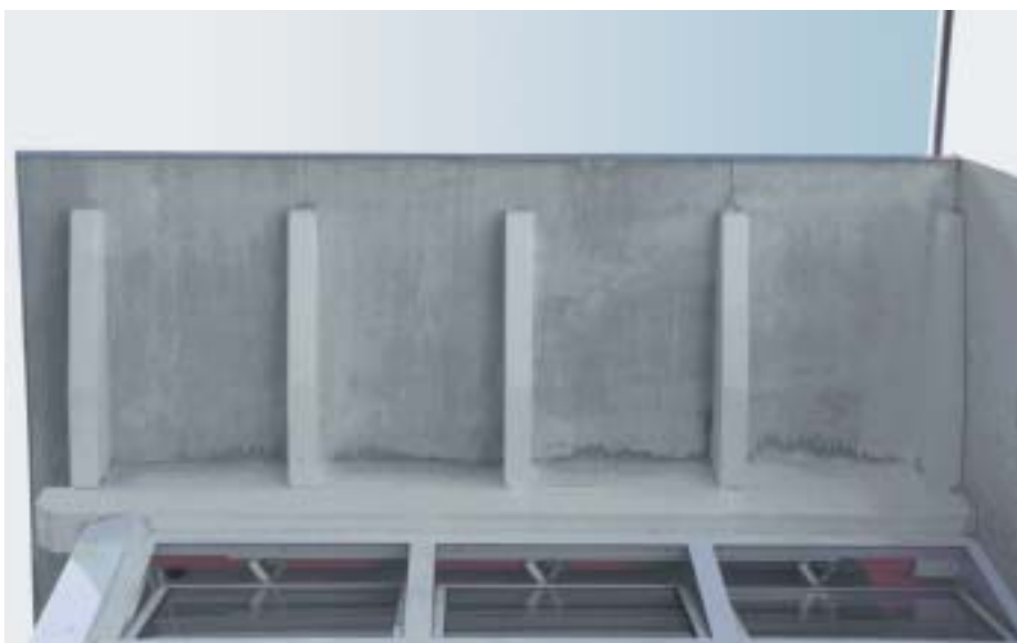
Flächiger Pilzbefall auf den Holzwerkstoffplatten einer Dachuntersicht. Es fällt auf, dass die Platten befallen sind, nicht jedoch die Sparren.
