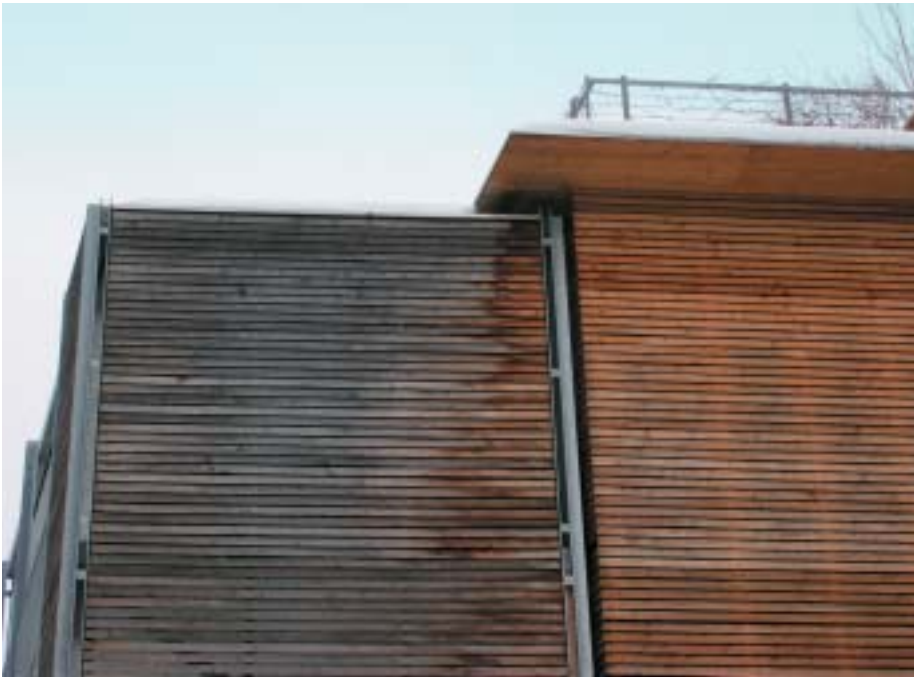
Manche Holzfassaden haben zwar punkto Beständigkeit kein Problem, weisen aber wegen ungleichmässiger Abwitterung ästhetische Mängel auf. (Foto: Alexander Jacobi)
