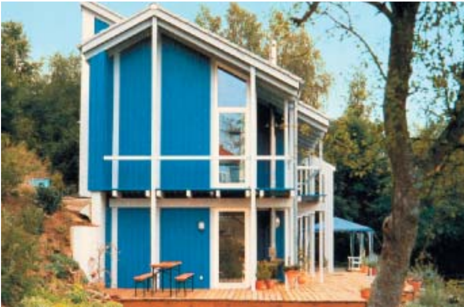
2 Die blaue Fassade dieses Hauses in Südfrankreich lässt den Aufenthalt auf der Terrasse im Sommer als weniger heiss empfinden als der frühere rote Anstrich.
