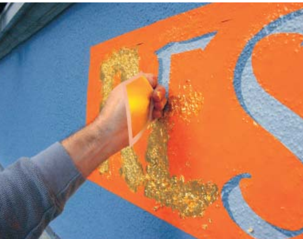
Beim Vergolden der Fassadenbeschriftung. (Foto: Beat Soller)
