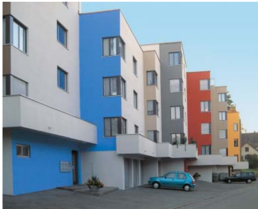
3 Bei diesen Eigentumswohnungen an der Püntstrasse in Horgen wurden bei der Renovation im Jahr 2003 nur die östlichen Fassadenvorsprünge farblich akzentuiert. (Foto: Walter Suter, Horgen)
