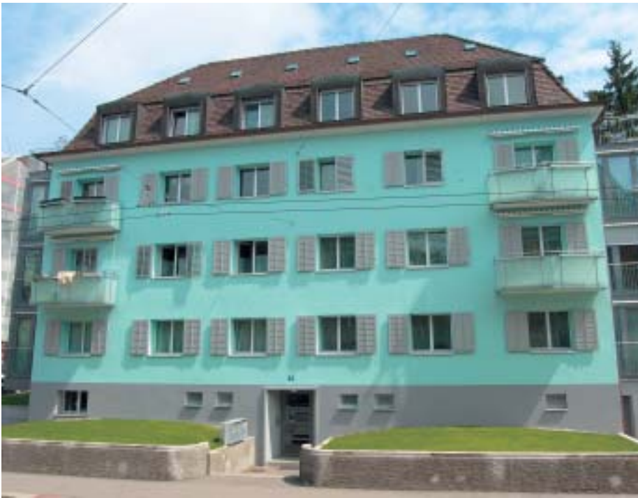
2 Genossenschaftswohnungen an der Waffenplatzstrasse in Zürich-Enge, 2004 umgebaut und renoviert. Man wird den Eindruck nicht los, dass hier Farbe um der Farbe willen eingesetzt wurde.
