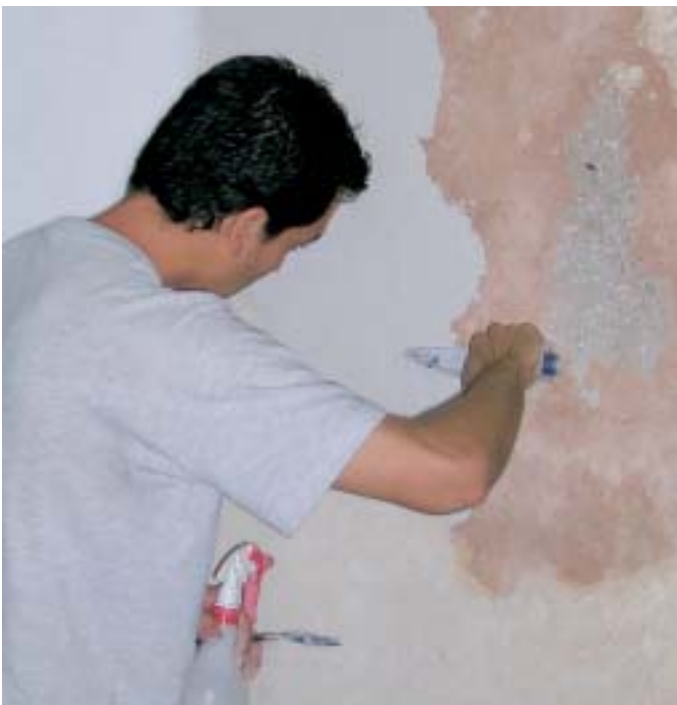
Weil meistens mehrere Malschichten übereinander liegen, ist es oft schwierig zu entscheiden, was freigelegt werden soll.
