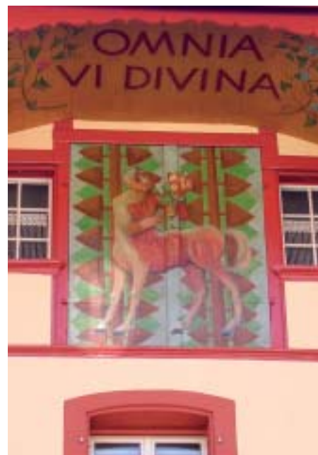
Die Estrichtür mit einem Zentauren und darüber der Spruch «Omnia vi divina» (alles durch göttliche Kraft) am Dachhimmel der Apotheke Dr. Fehlmann nach der Restaurierung.
