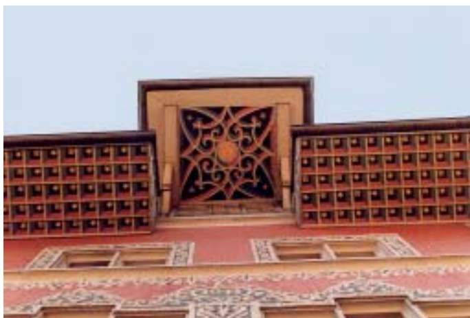
Haus an der Rathausgasse 22 mit einer frühbarocken Sgraffitodekoration mit der Jahreszahl 1641 an der Fassade, darüber ein «moderner» Dachhimmel mit Blumen und Sternen in einem Rastersystem, dazwischen eine reich verzierte Sonne.
