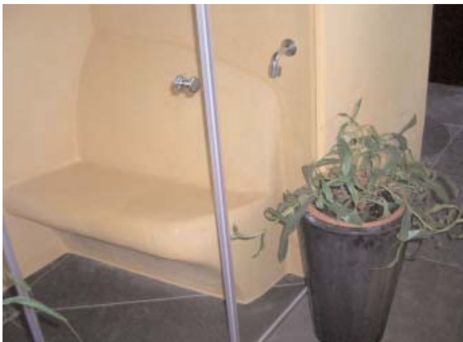
Diese Saunasitzbank wurde – wie auch die Wände – mit Tadelakt verputzt. Der effektive Farbton zeigt sich erst nach vollendeter Trocknung, die bis zu drei Tage in Anspruch nehmen kann.
