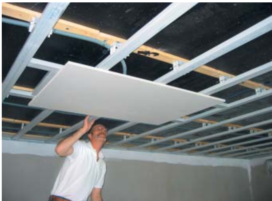
Nach eingehender Kontrolle und einer Funktionsprüfung der Beschallungsanlage kann die Decke vollständig montiert werden.
