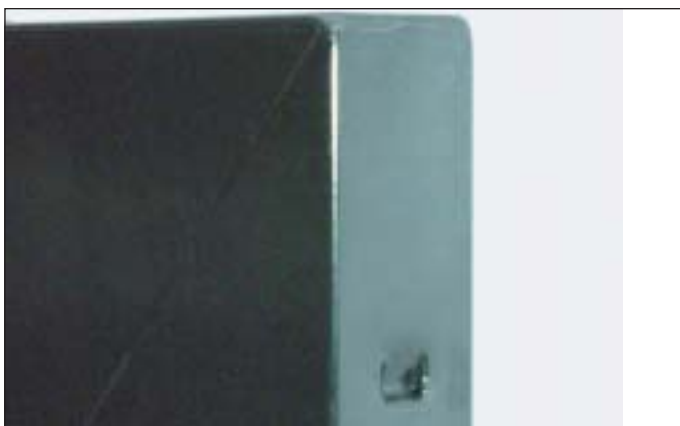
Ob Alu-Fensterläden gepresst sind, erkennt man an den stirnseitigen Pressmarkierungen.
