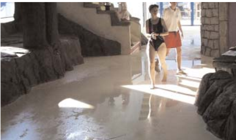
Stürze durch Ausgleiten können durch gute Bodenfarben vermieden werden. Wichtig ist dies vor allem in Bereichen, wo der Boden nass sein kann.
