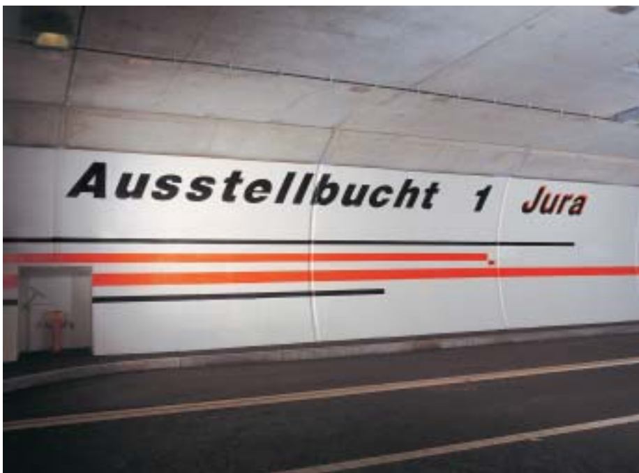
Auch in Strassentunnels werden Epoxidanstriche eingesetzt.
