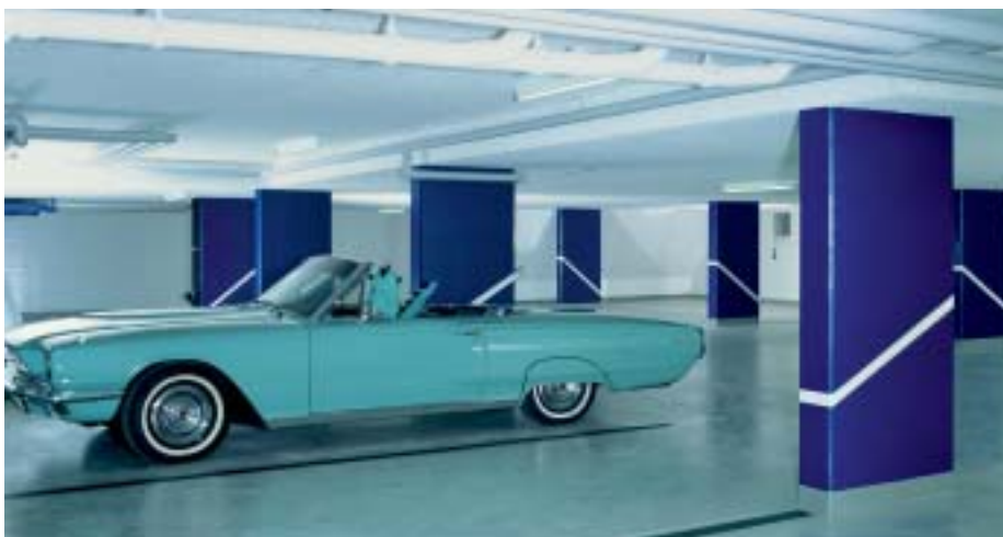
Für Boden- und Wandversiegelungen wie hier in einer Tiefgarage haben sich wasserverdünnbare Zweikomponenten-Epoxidharzversiegelungen bewährt.
