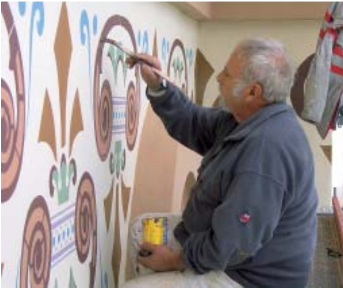
Die Renovationsarbeiten erfordern vom Maler grosses Können.
