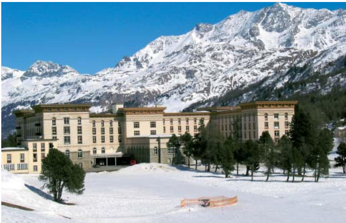
Am riesigen Komplex des Hotels Maloja Palace im Oberengadin (zwischen Silsersee und Malojapass) wird von 2004 bis 2006 die Fassade renoviert.
