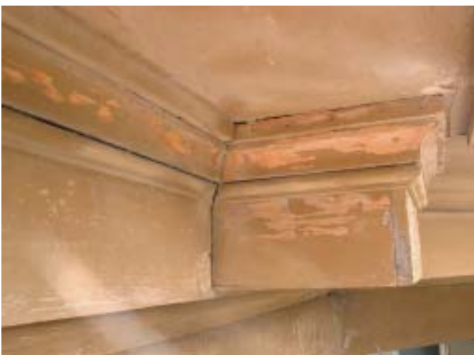
Detail der Dachuntersicht während der Untergrundvorbehandlung.
