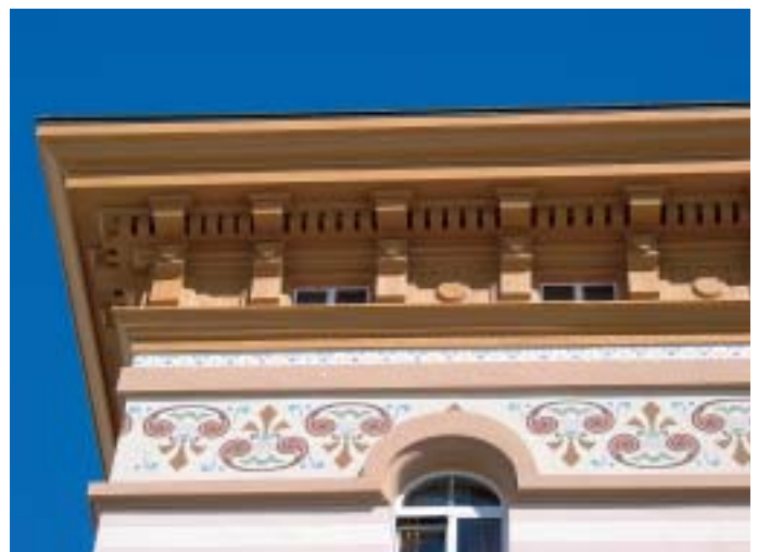
Dachuntersicht nach der Renovation.
