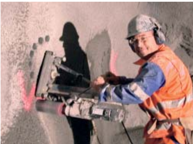
Häufig müssen auf der Baustelle Bohrkern entnommen werden, die dann im Labor untersucht werden.
