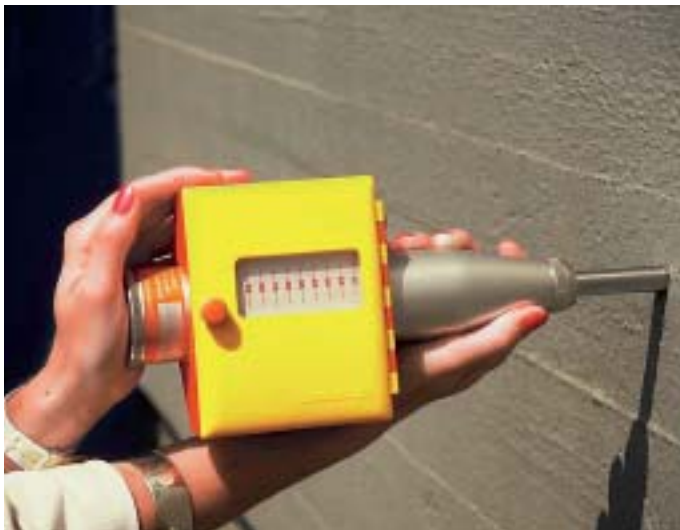
Hier wird die Betonfestigkeit mit dem Schmid-Hammer geprüft.
