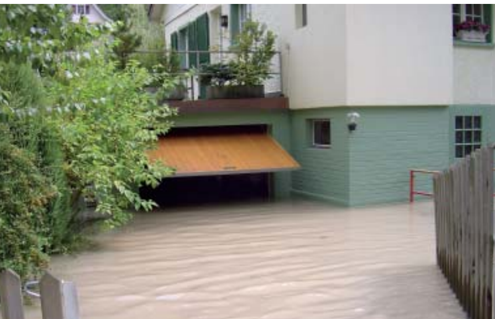
Hochwasserschäden in der Schweiz im August 2005: Das Mattequartier in Bern wurde besonders hart getroffen. (Foto: Gebäudeversicherung Bern)
