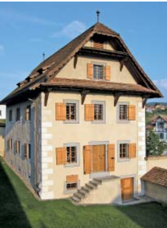
6 Der Spycher mit fertig verputzter Westfassade und in transparentem Weiss gefassten Eckquadrierungen.
