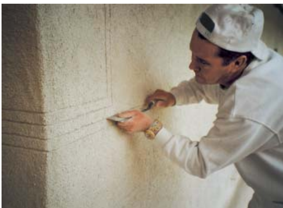
5 Die Eckquadrierungen am Spycher wurden mit einem Sägeblatt eingeritzt. (Foto: Schöpfer & Debon, Kriens)
