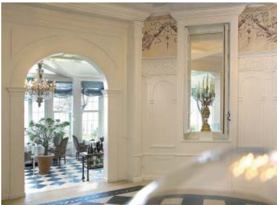
Der Eingang zum Restaurant «Wintergarten» wurde von grossen Eingriffen verschont. Die Holzwände erhielten einen neuen Anstrich auf Acrylbasis.
