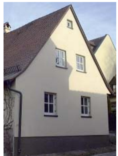
3 Wegen des geringen Dachüberstandes konnte dieses denkmalgeschützte Zweifamilienhaus in Nürnberg nur mit Vakuum-Isolations-Paneele gedämmt werden (links vorher, rechts nachher). (Foto: Bayerisches Zentrum für Angewandte Energieforschung, ZAE Bayern)
