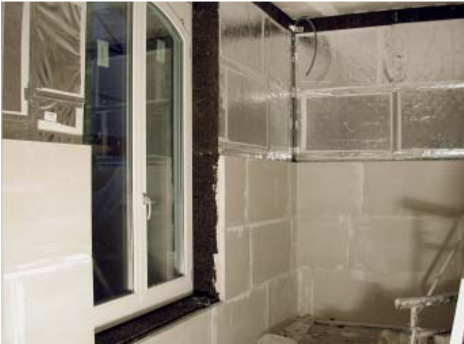
2 In einem Zürcher Altstadtthaus wurden Vakuum-Isolations-Paneele als Innendämmung eingesetzt. Der mechanische Schutz erfolgte durch eine selbsttragende Vorsatzschale aus Vollgipsplatten. (Architekt und Foto: Viriden + Partner)
