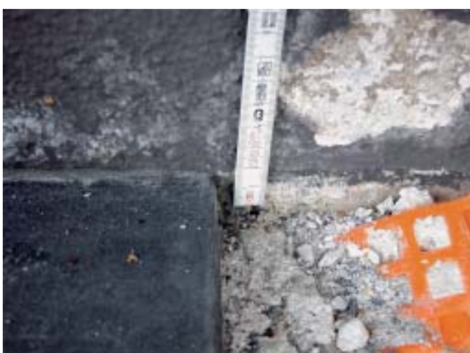
10 Die Natursteinplatten wurden mit einem nur sehr geringen Gefälle an die Aussenwand angeschlossen. Im Bereich der Platten wurde keine Schutzbeschichtung ausgeführt. Der Anschluss an die Hauswand erfolgte mit einer Kittfuge. Nach relativ kurzer Zeit entstanden weisse Ausblühungen, verursacht durch Feuchtigkeitseinwirkung auf den Putz.
