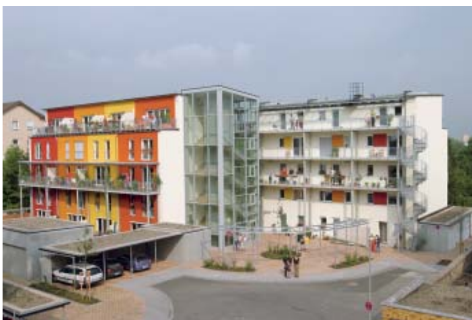
Bei diesem Passivhausprojekt in Frankfurt-Bockenheim sind 8 von 19 Wohnungen fast genau nach Norden ausgerichtet. Sie verbrauchen mit 14,4 \text{ kWh/m}^2\text{a} nur 4 \text{ kWh/m}^2\text{a} mehr als die Wohnungen im Südhaus. Geplant und betreut wurde das Projekt vom Darmstädter Architekturbüro «Faktor 10». (Foto: Faktor 10)
