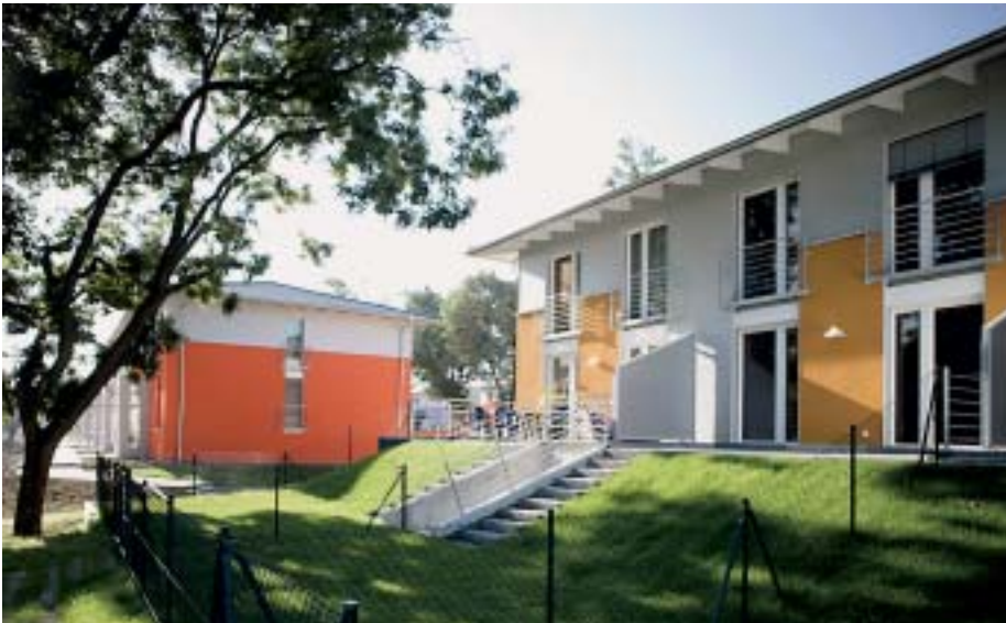
Unter der Mitarbeit des Passivhaus-Instituts entstanden Neubauwohnungen, die nur etwa 1 Liter Heizöl pro Quadratmeter Wohnfläche im Jahr benötigen. Sie sind mit einem 30 cm dicken Wärmedämmverbundsystem ausgestattet. (Foto: Caparol)
