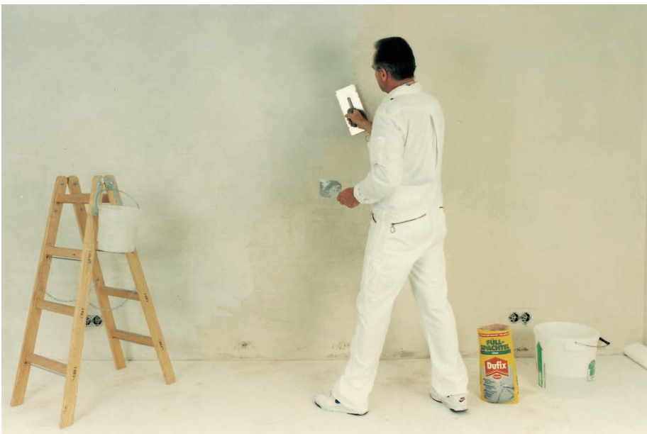
Eine vollflächige Spachtelung ergibt einen glatten Untergrund.
