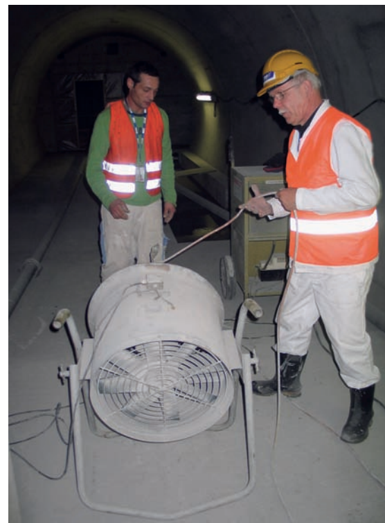
Vor dem Bemalen müssen die Betonwände getrocknet werden.
