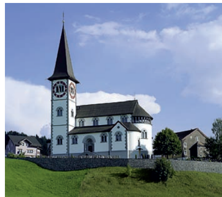
Nordansicht des Gotteshauses in Haslen nach der Aussenrenovation von 2004. (Foto: Lehmann Fotostudio, St. Gallen)
