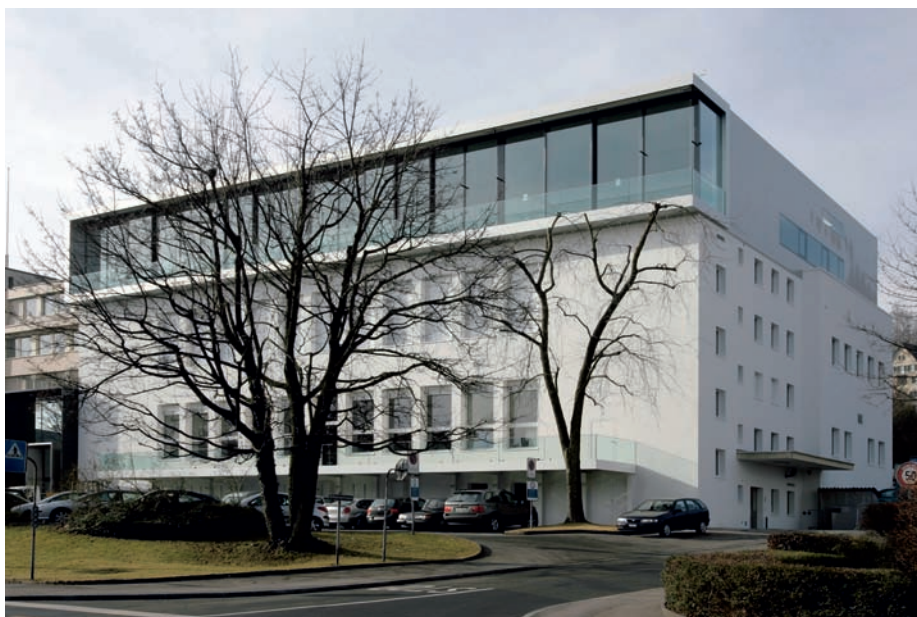
Dieses Gebäude der Schokoladefabriken Lindt & Sprüngli in Kilchberg wurde um zwei Etagen aufgestockt. Aus Gewichtsgründen wurden die Wände in Gipstrockenbauweise ausgeführt. (Foto: Felix Frey)
