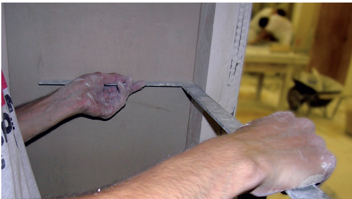
Die Masstoleranzen für Ebenheit, Flucht und Senkel sowie Länge und Winkel wurden klar festgelegt.
