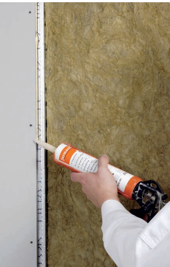
Beim Einsatz in Badezimmern brauchen lediglich die Eckanschlüsse abgedichtet zu werden.
