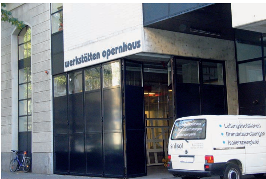
Nüchtern von aussen, bunt und märchenhaft im Innern: Die Werkstätten des Opernhauses an der Seerosenstrasse in Zürich.
