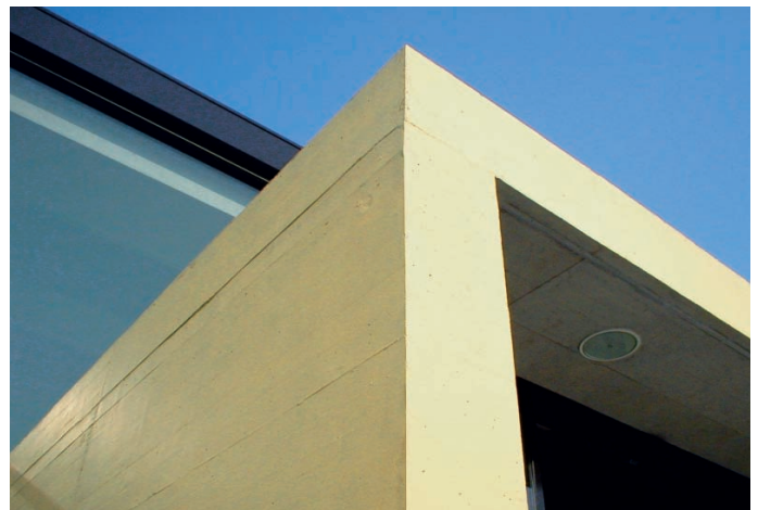
Sowohl aussen als auch innen wurde der Beton dieses Gebäudes mehrmals mit einer stark verdünnten silikatischen Dünnschichtfarbe lasiert, die eine Hydrophobierung beinhaltet. (Foto: Peter de Kleine)
