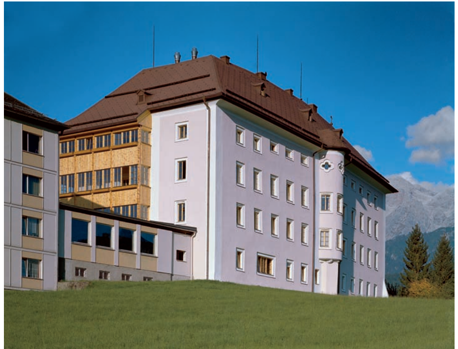
Das unter Denkmalschutz stehende Seniorenwohnhaus Schloss Farmach in Österreich erhielt 1990 ein neues Wärmedämmverbundsystem mit Strukturputz und Dispersions-Silikatfarbe. (Foto: Sto)
