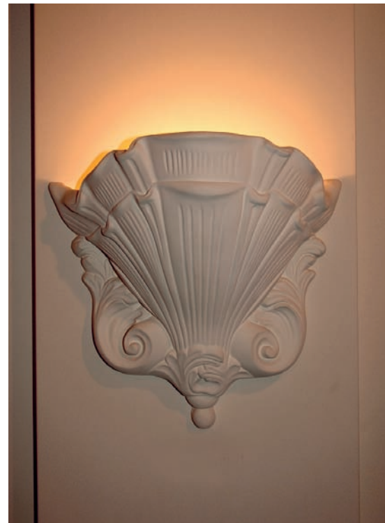
Stuckelement, kombiniert mit indirekter Beleuchtung.
