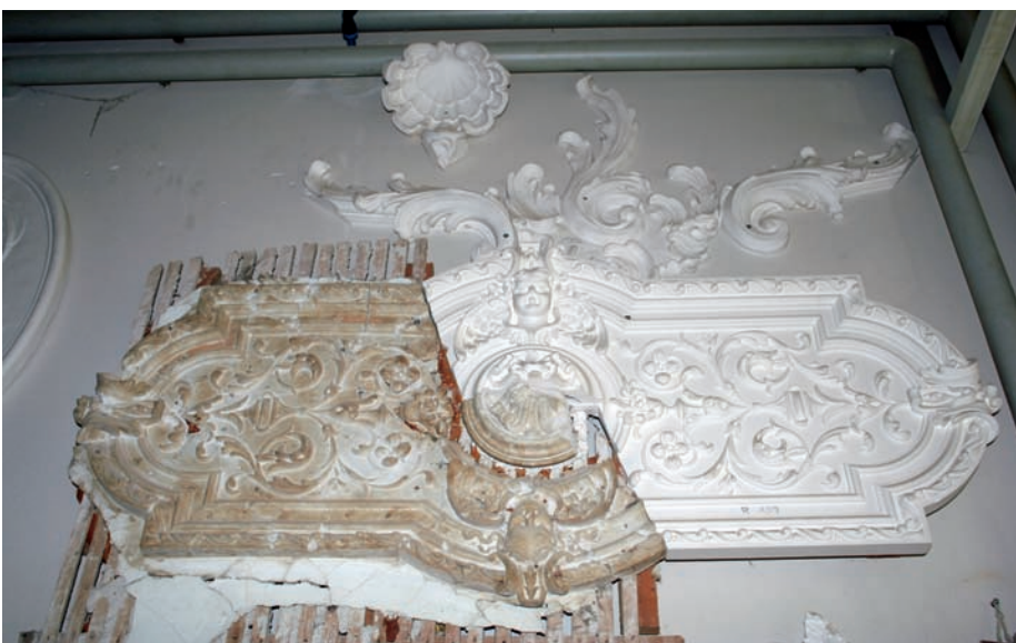
Beim Restaurieren ist grösste Präzision gefragt, denn der Stuck soll aufs Genaueste reproduziert werden.
