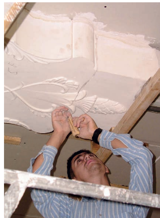
Vollendung: Gipser Burim Imeri putzt Rissbildungen zu.
