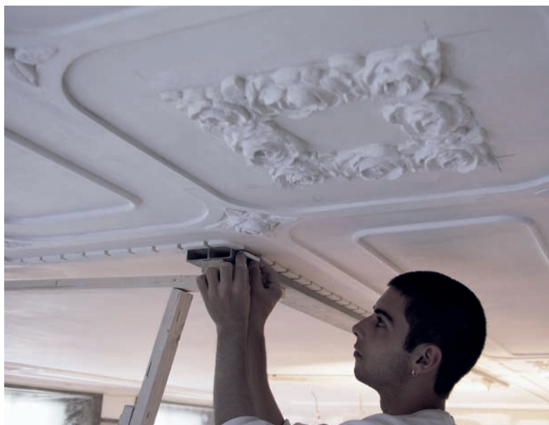
Lehrling Pedro Pereira beim Anbringen der geometrischen Deckenstuckaturen.
