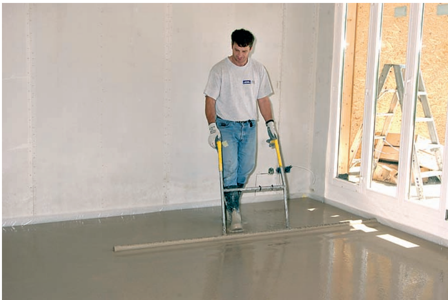
1 Calciumsulfat-Fliessestriche sind zwar schnell verlegt, erfordern aber viel Fachwissen und eine sorgfältige Planung.
