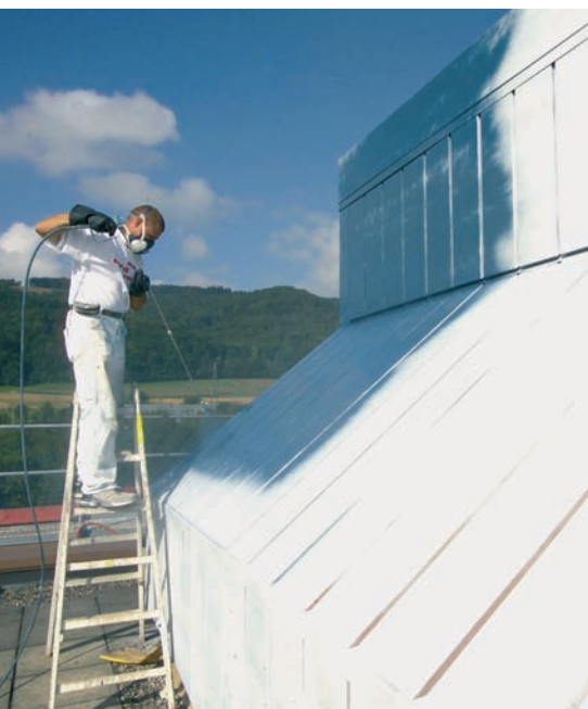
In luftiger Höhe wurde der lösemittelhaltige, glänzende 2K-Polyurethanlack mit zwei Hochleistungs-Airless-Geräten verarbeitet.
