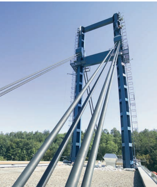
Der Stahlpylon erhielt eine Einkomponentenbeschichtung auf Silikon-Alkydharz-Basis.
