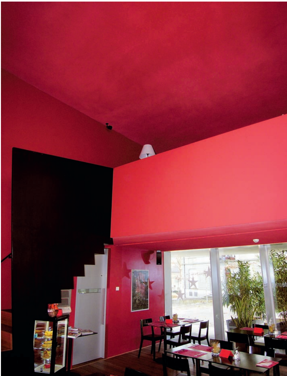
Die Cafeteria des Museums Franz Gertsch in Burgdorf gestaltete die Wüthrich AG mit Gipsbauplatten. Für die Deckenverkleidung verwendete sie Akustikplatten.
